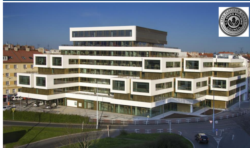
Vzhled budovy po rekonstrukci
