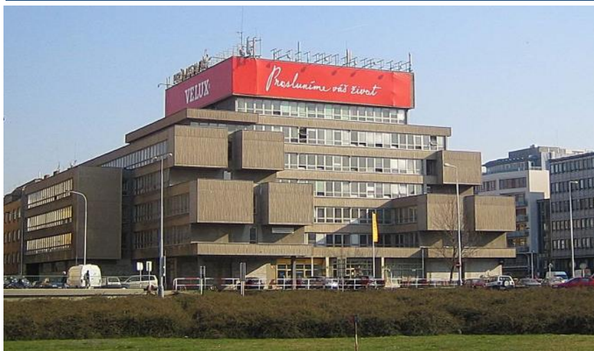
Vzhled budovy před rekonstrukcí
